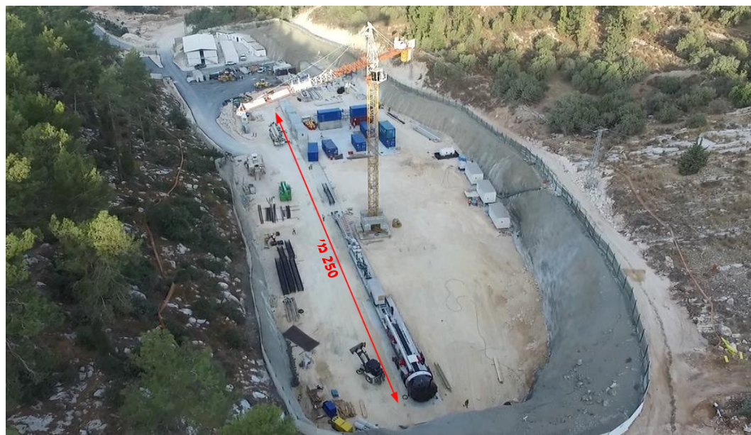
איור 4. עבודות הרכבת מכונת ה- TBM - Open shield בשלביה הראשונים
