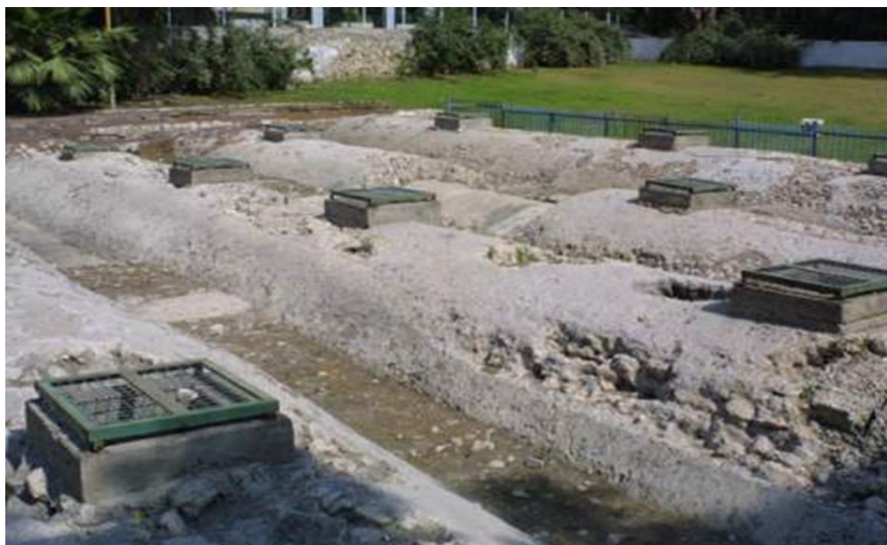
איור 17: פתחים לתאורה ולהוצאת מים מותקנים על גבי הקמרונות המכסים את הבריכה
